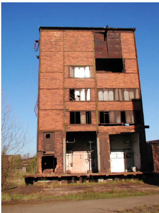
rozvodna u líčho stroje od východu
