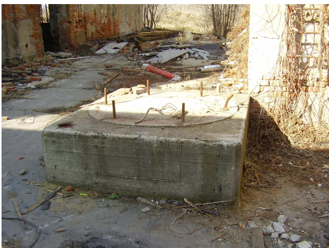
Obr. č. 3: Jímka za objektem kompresorovny
