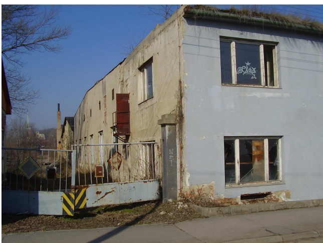
Obr. č. 1: Vjezd do areálu před demolicemi
