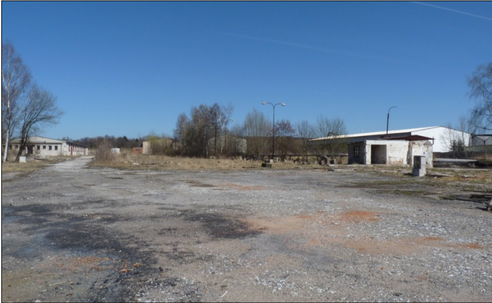
Obrázek 1: Centrální část areálu s relikty pilnice a řetězového dopravníku uprostřed
