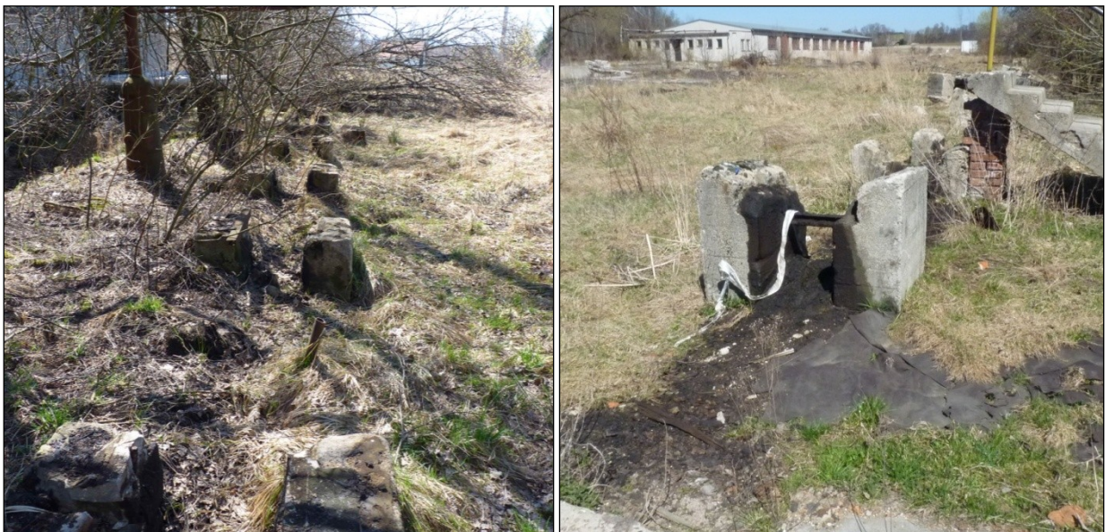
Obrázek 3: Kontaminovaná linie bývalého řetězového dopravníku a jeho patek
