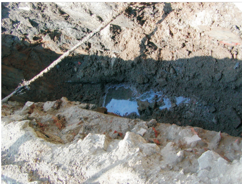
Foto č. 2: Detail výkopu s vodou
