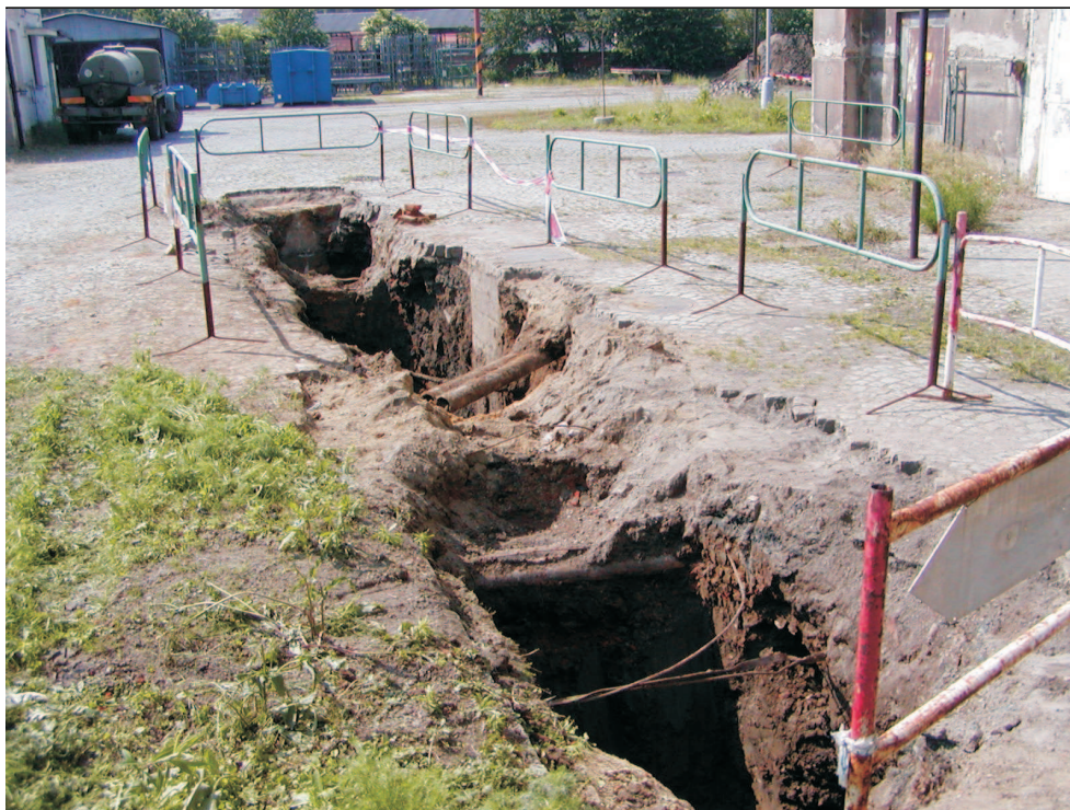
Foto č. 1: Výkop pro odtěžbu staré chemické kanalizace
