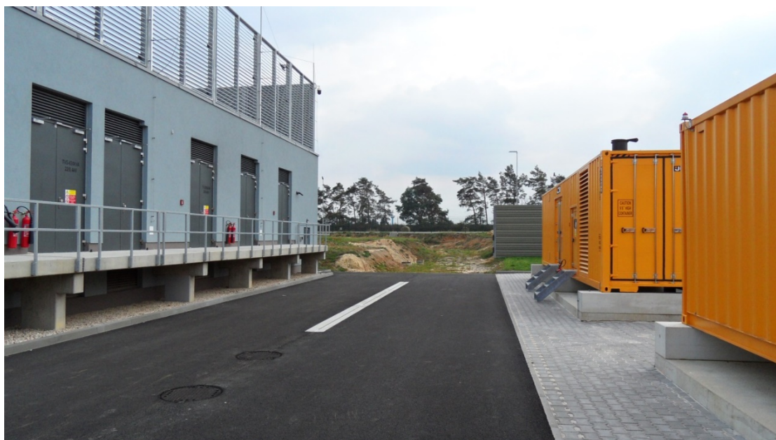
Obr. 5 Vlevo zadní část budovy datového centra s trafostanicemi, vpravo energocentrum
