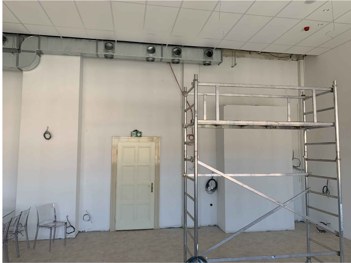
stěna se vstupními dveřmi - pro vestavěnou skříň
