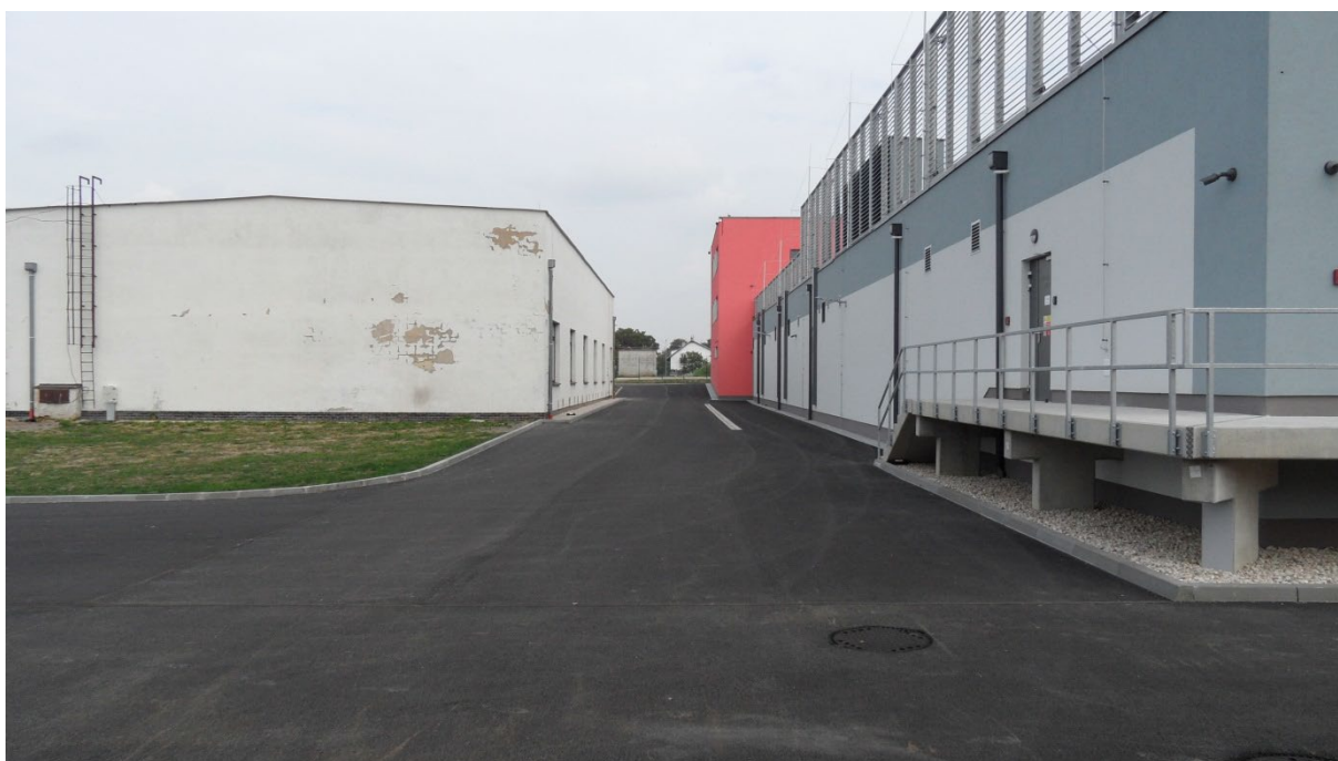
Vlevo budova garáží, vpravo budova datového centra
