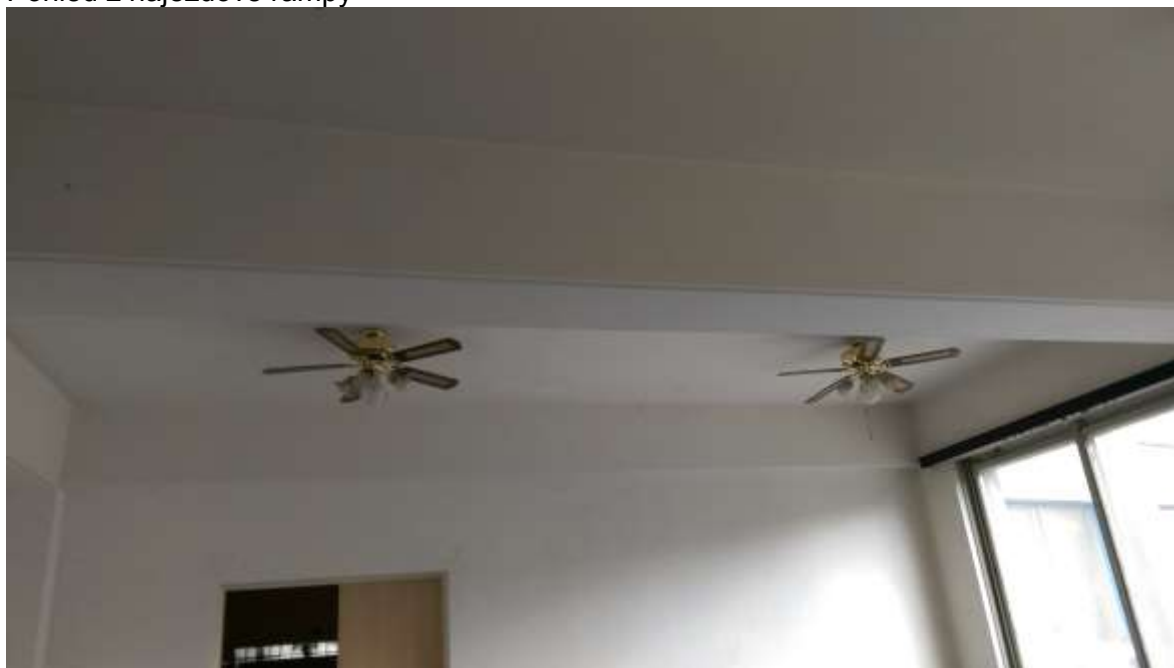
Strop v malé části místnosti
