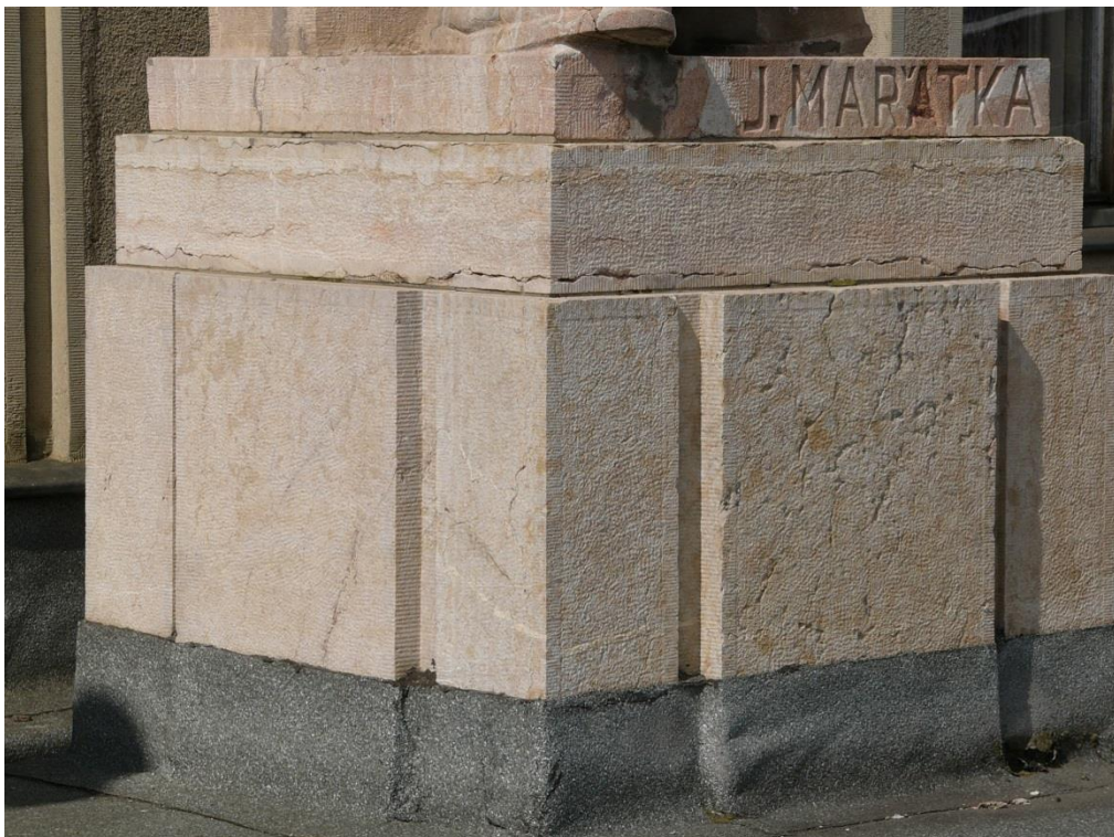
Sokl sochy z pravého předoboku: hloubkové trhliny a degradace kamene v kvádrech soklu
