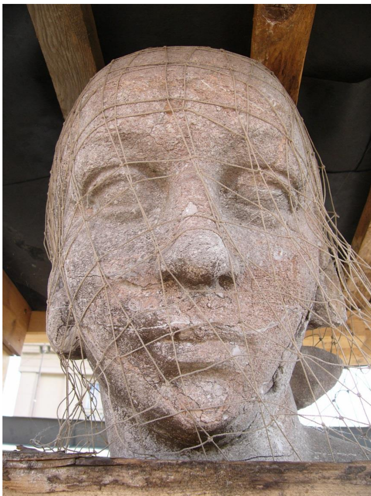
Hlava ze předu: množství větších i menších trhlin po celém obličej
