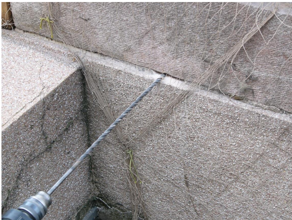
Zjišťování kotvícího čepu metodou navrtávání spáry u sochy na atice budovy
