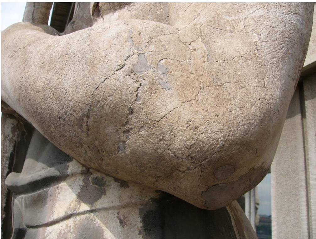
Detail levého předloktí: trhliny v celé oblasti lokte a předloktí, viditelná krusta v dešťových místech
