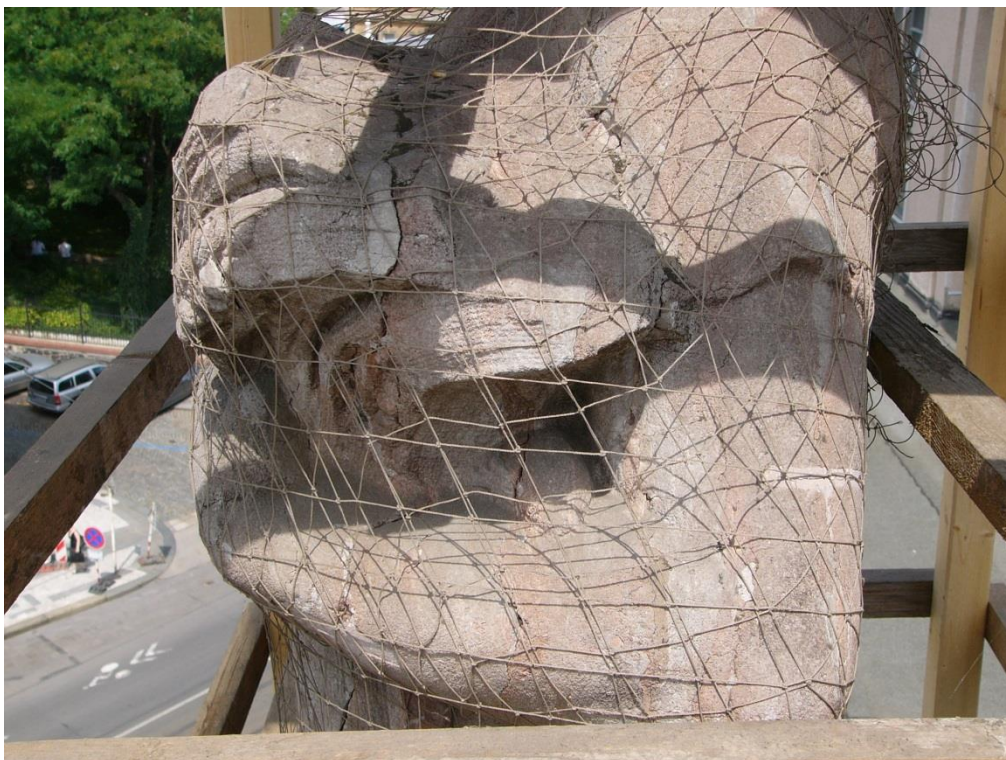
Trup s klasy z levé strany: statické trhliny po celé délce, drobné praskliny, lišejníky
