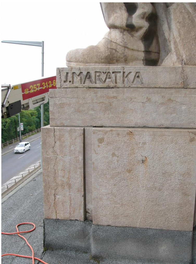
Detail soklu: výrazné hloubkové narušení kamenných kvádrů soklu
