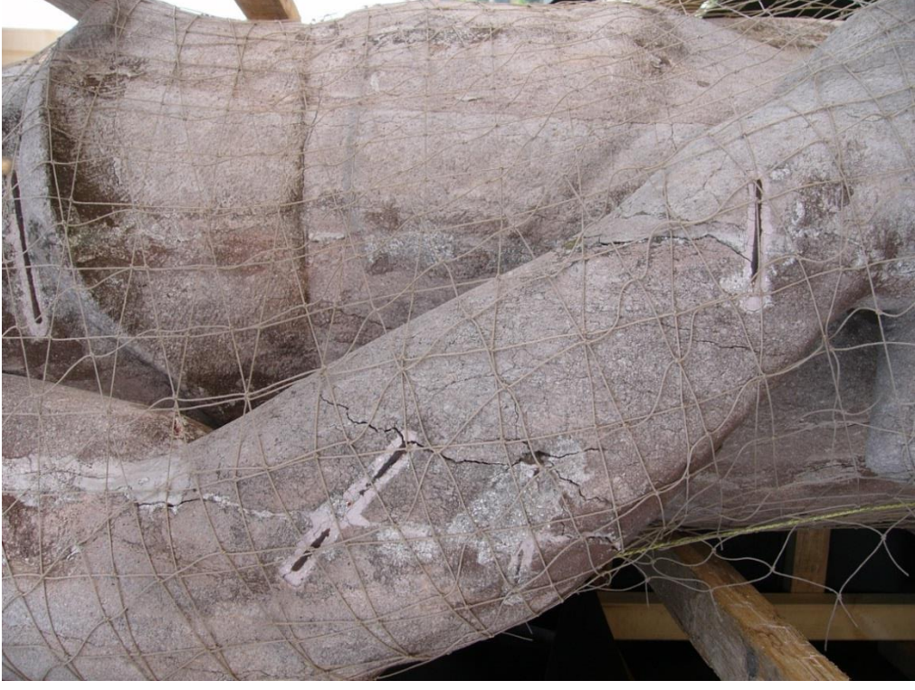
Bok z pravé strany: viditelné statické trhliny, síť drobných prasklin, zajišťovací kramlíčky
