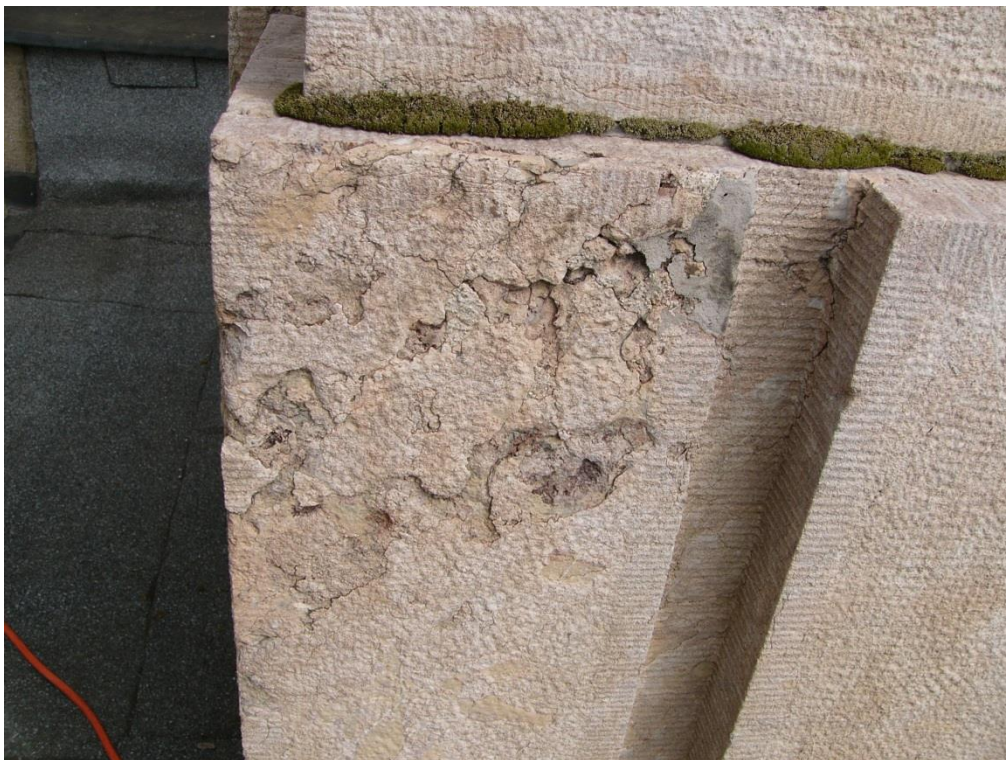
Detail soklu: výrazné hloubkové narušení kamenných kvádrů soklu
