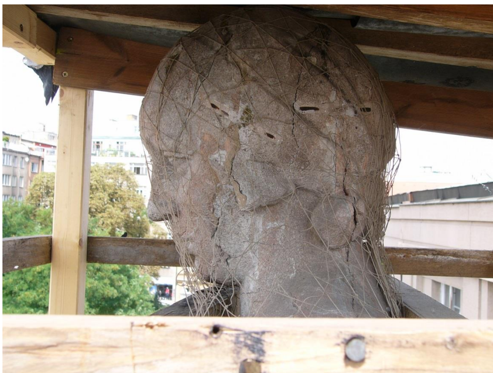
Hlava z levé strany: statické i menší trhliny po celé hlavě, zajišťovací kramličky, lišejníky
