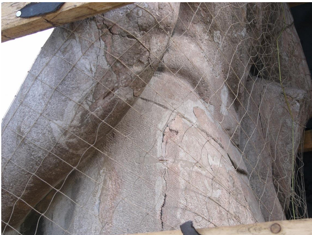
Zadní část trupu: statické i drobné praskliny po celé ploše těla, zabezpečovací kramličky
