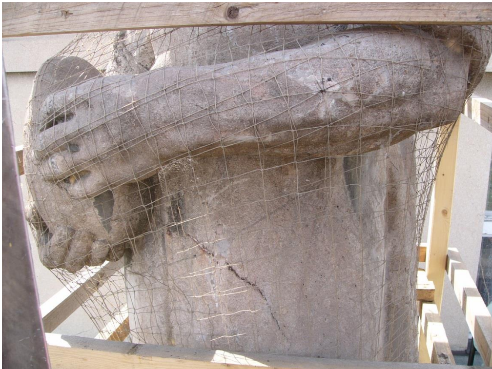
Levá ruka a bok: trhlina na levé straně drapérie a praskliny po celé ruce i drapérii
