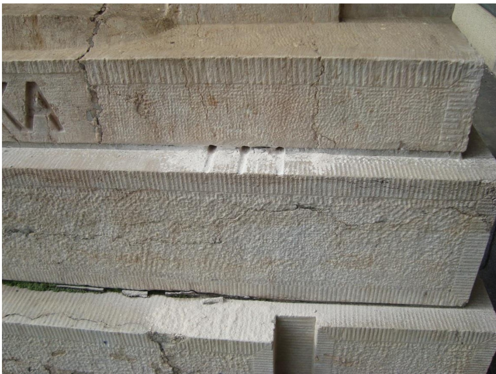
Zjišťování kotvícího čepu u sochy v průčelí, nad vchodem do budovy, metodou navrtávání spáry
