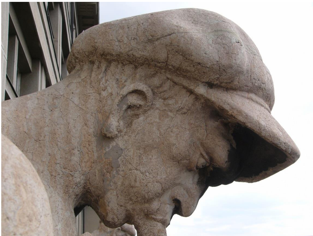
Hlava z pravé strany: velké i malé praskliny v celé ploše hlavy
