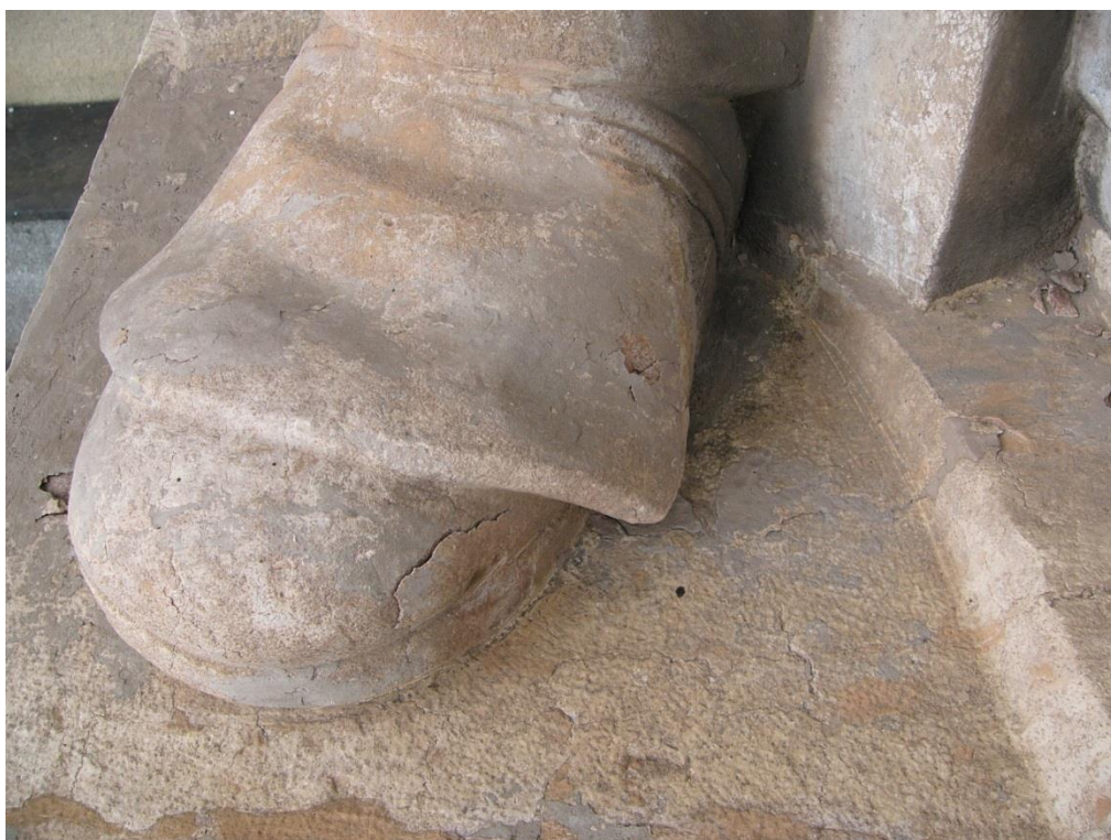
Detail pravé boty: praskliny zapříčiňující ztrátu materiálu, praskliny na celé ploše plintu i částí sochy
