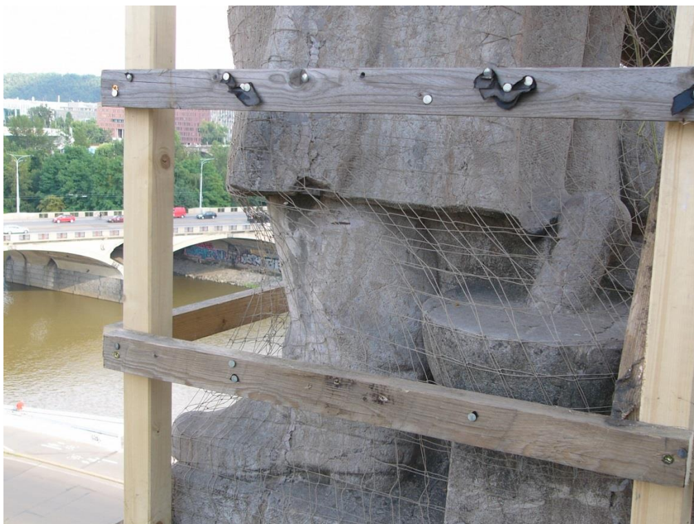
Spodní část sochy z levé strany: statické trhliny po celé délce nohy a drapérie, síť drobných prasklin po celé ploše
