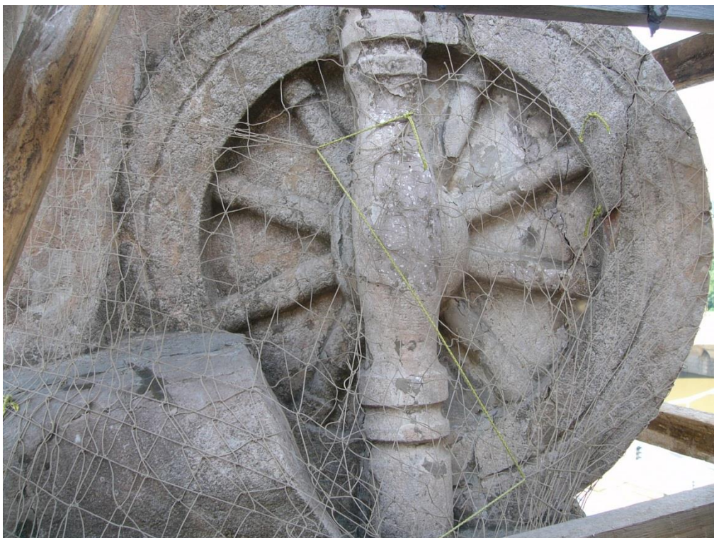
Detail kolovrátku: výrazné pavučiny větších i drobných prasklin, zapříčiňující odpadávání kamenného materiálu
