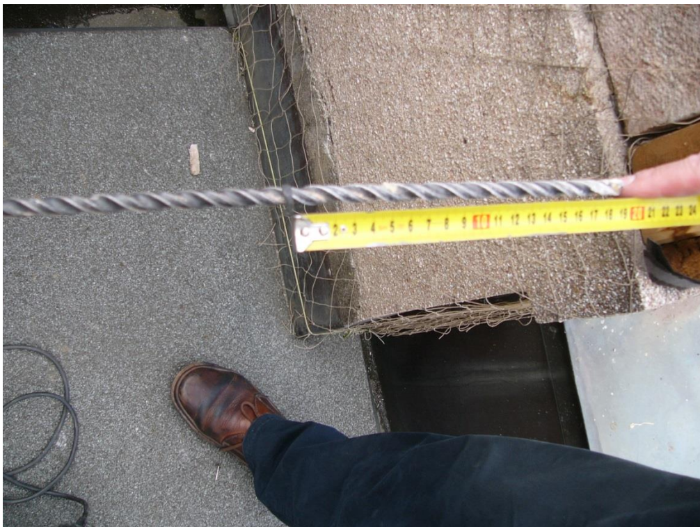
Délka vrtu ke kotvicímu čepu
