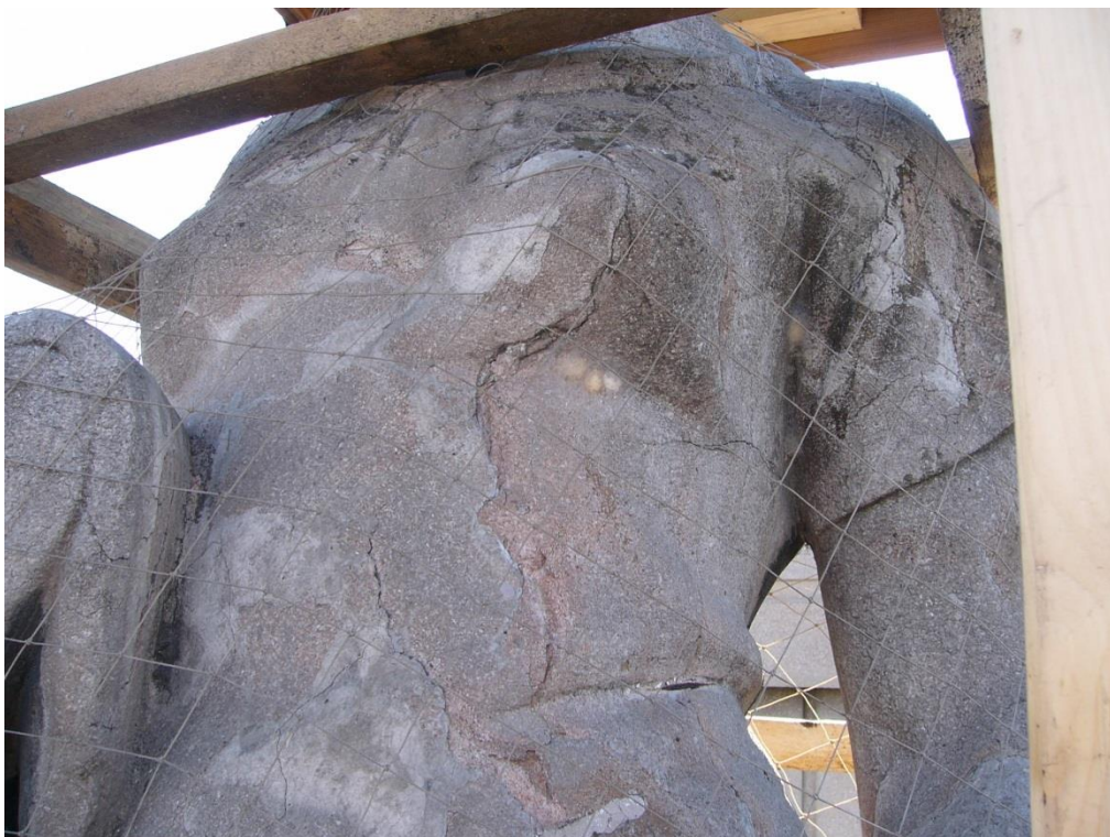
Přední část trupu: statické i drobné trhliny po celé délce trupu, zabezpečovací kramnličky, krusta
