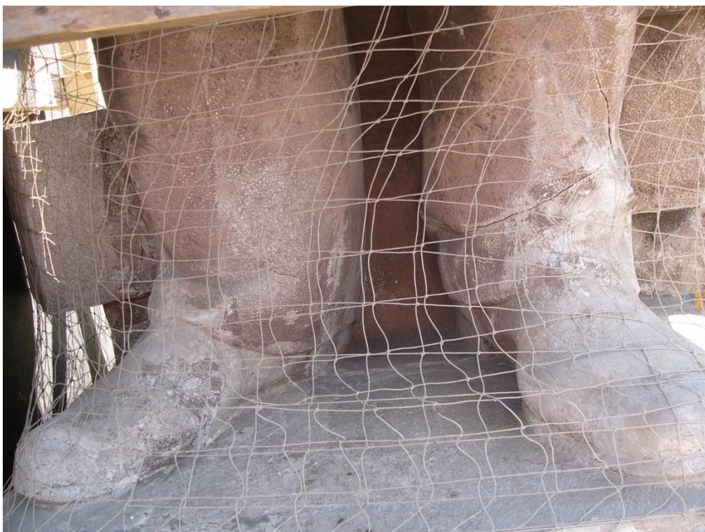
Nohy z předu: statická trhliny na levé noze a množství menších trhlín na pravé i levé noze
