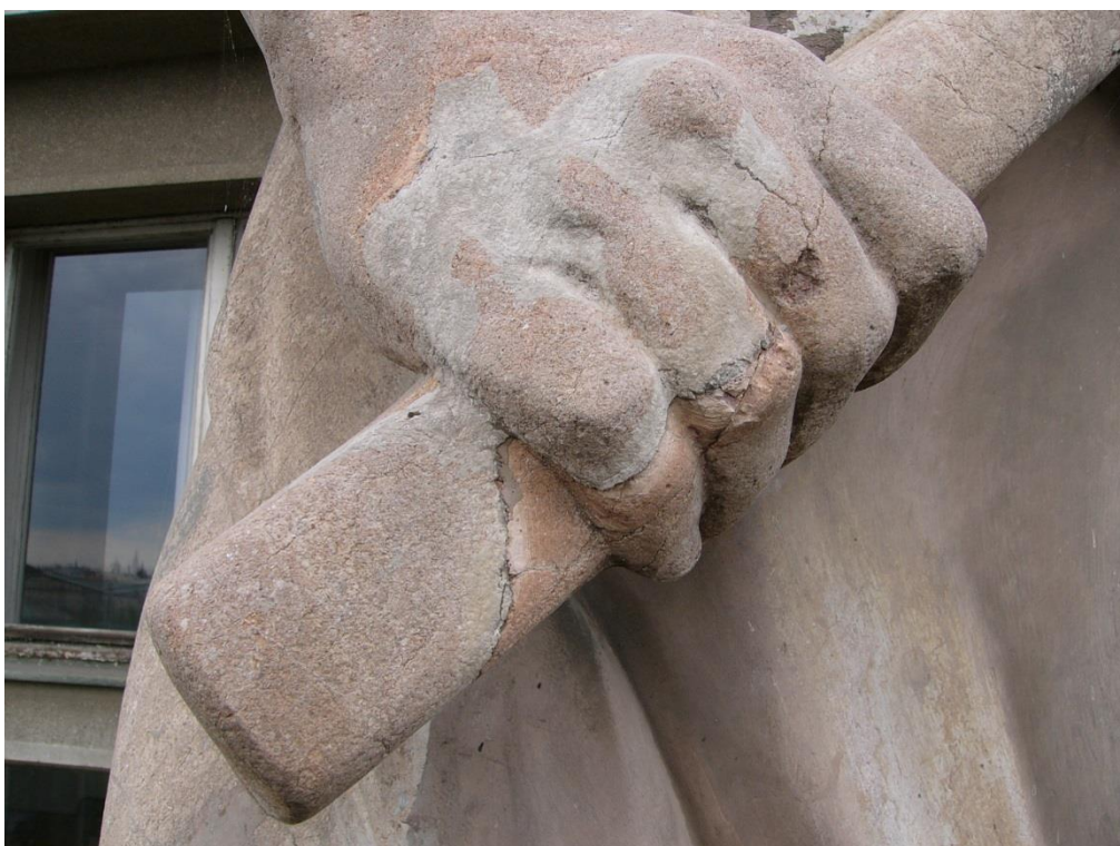
Detail pravé ruky držící kladivo: hloubkové i menší trhliny po celé ruce i násadě kladiva
