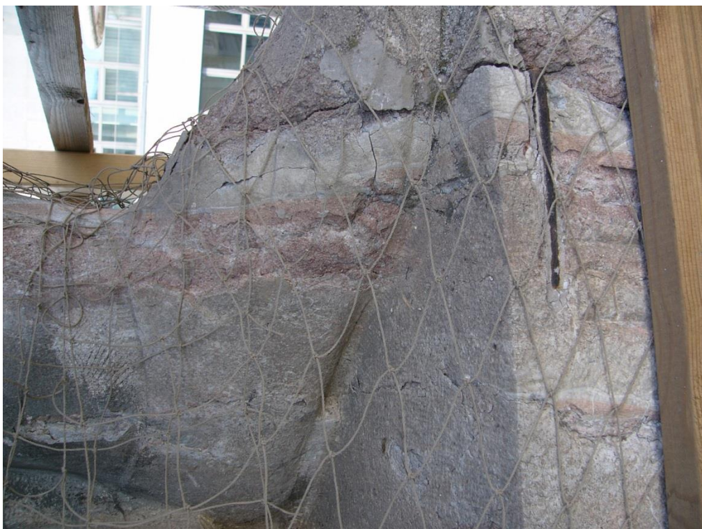
Detail zadní části: statické i drobné praskliny procházející po celé délce sochy, zabezpečovací kramlička
