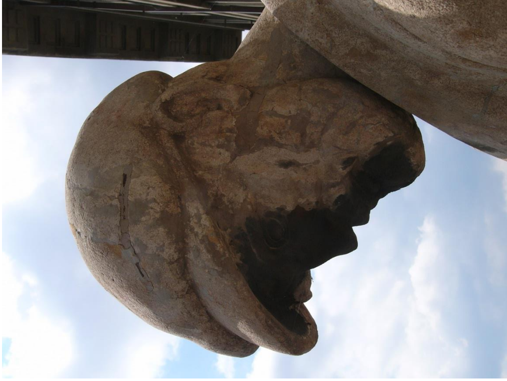
Hlava z levé strany: statické trhliny v oblasti čepice, krku a tváře, drobné praskliny v celé ploše hlavy
