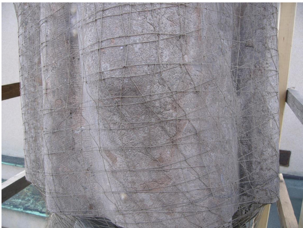
Spodní část drapérie ze předu: praskliny po celé ploše drapérie
