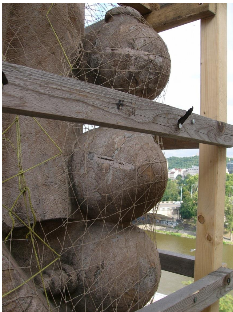
Spodní část sochy z levé strany: statické trhliny po celé délce nohy a drapérie, síť drobných prasklin po celé ploše
