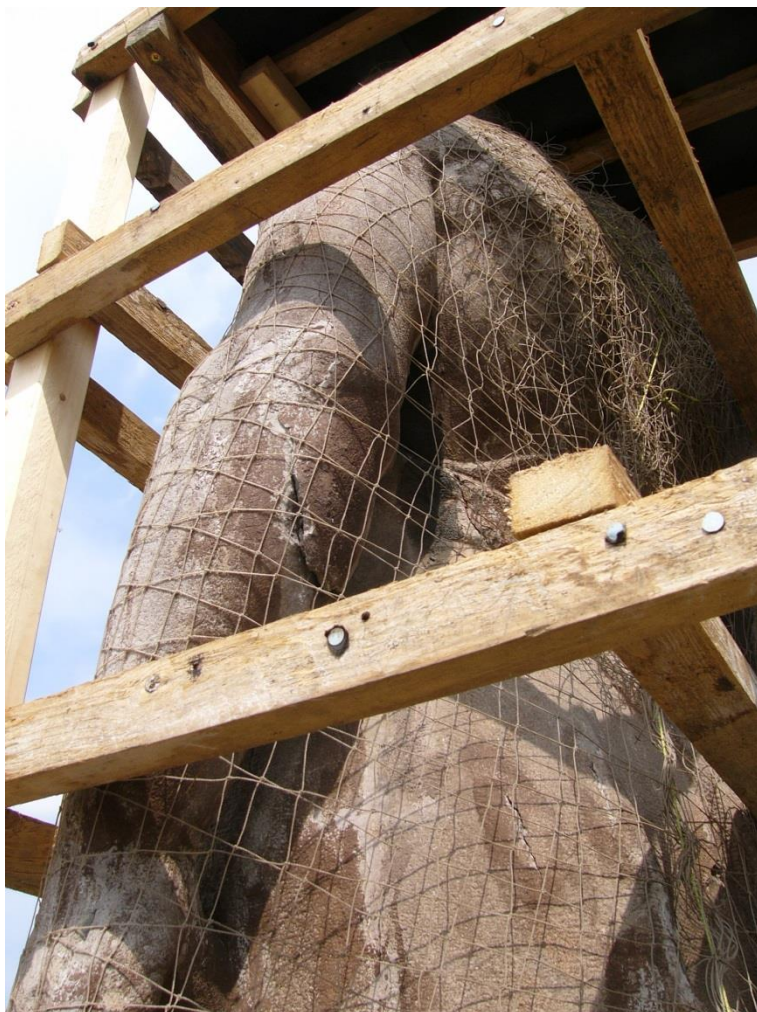
Levá paže a bok ze zadu: destruktivní trhlina na paži, trhliny na zádech a zadní partií
