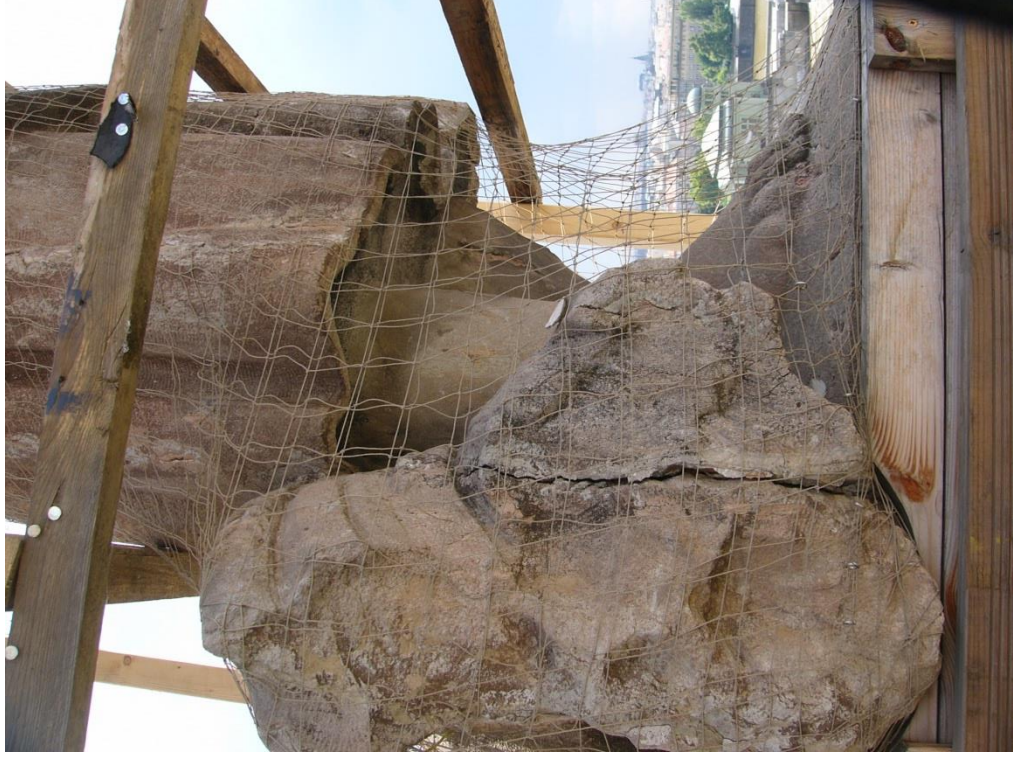
Spodní část skulptury z pravé strany: statická trhlina v hmotě kamene (klasy) i v pozadí na levé noze, praskliny v drapérii
