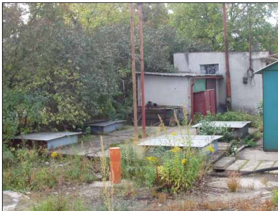
foto č. 8: Podzemní nádrže na naftu, v pozadí budova vrátnice, vpravo sanační stanice.
