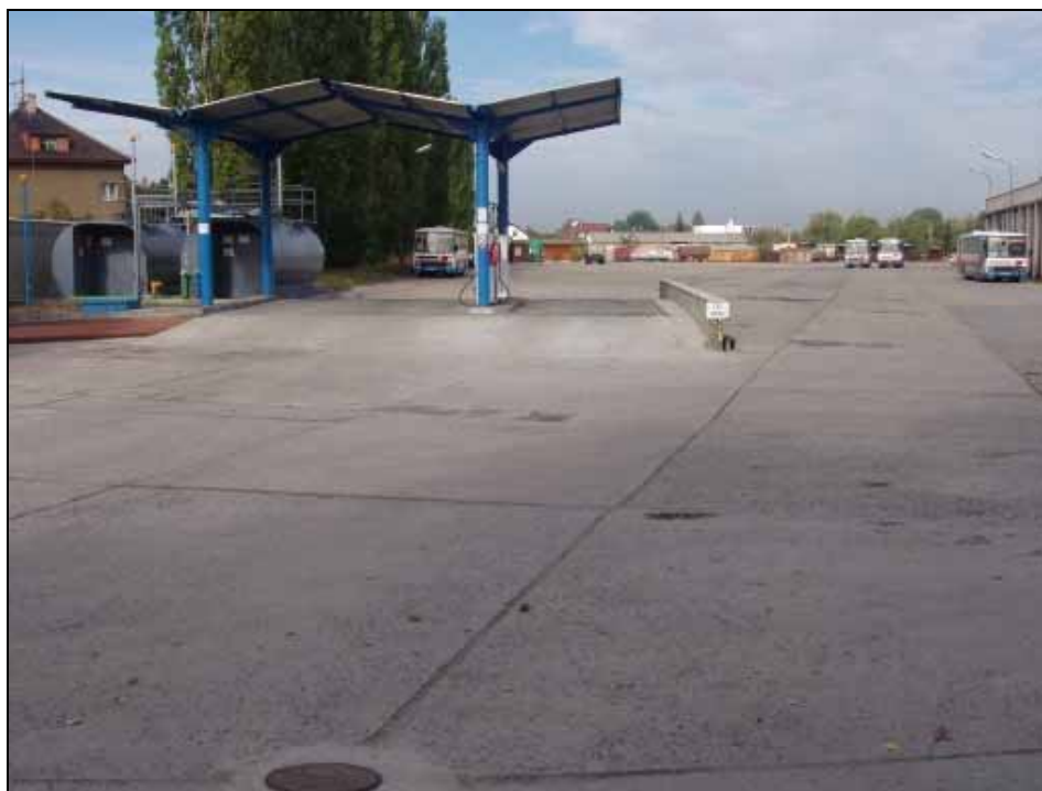
foto č. 15: Pohled na novou ČSPH a parkoviště v zadní části areálu (část tohoto prostoru bude možné využít pro mezideponii).
