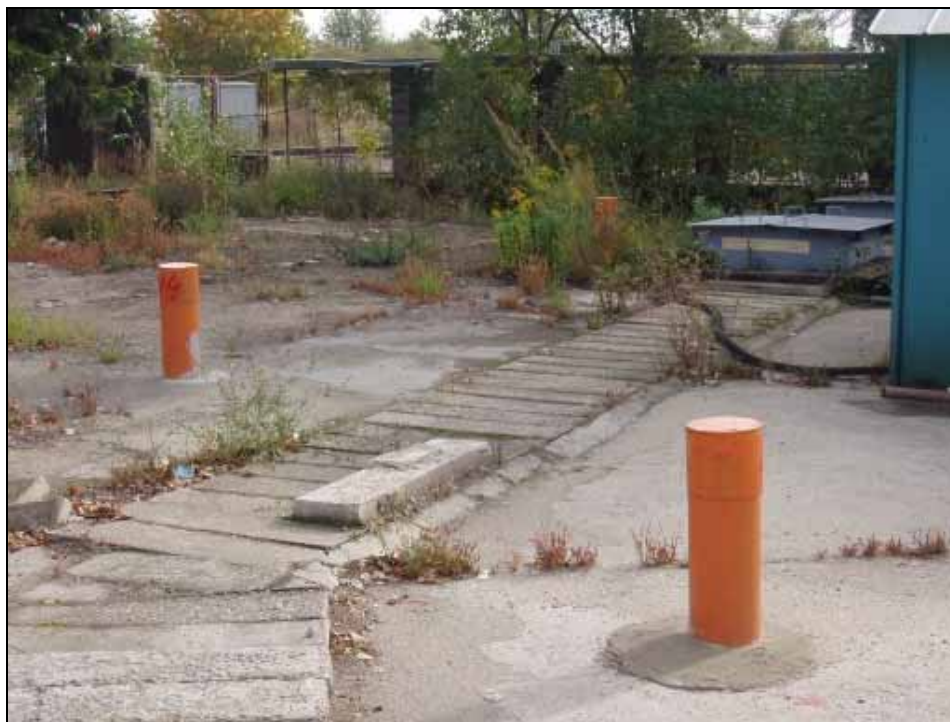
foto č. 7: Tepelný kanál, vlevo prostor bývalého olejového hospodářství, vpravo sanační stanice.
