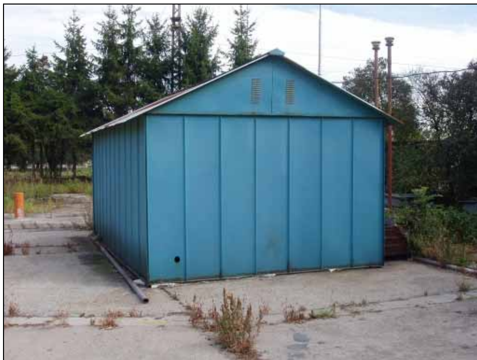
foto č. 9: Sanační stanice (pohled od vrátnice směrem k bývalému olejovému hospodářství).
