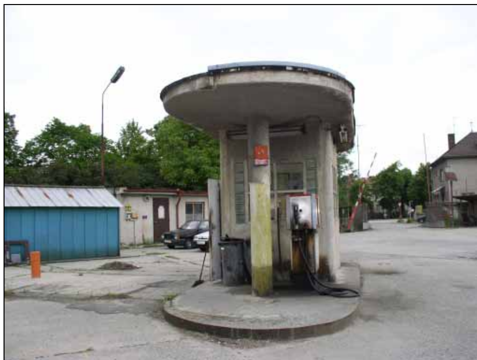
foto č. 2: Bývalá ČSPH, v pozadí sanační stanice, budova vrátnice a vjezd do areálu.
