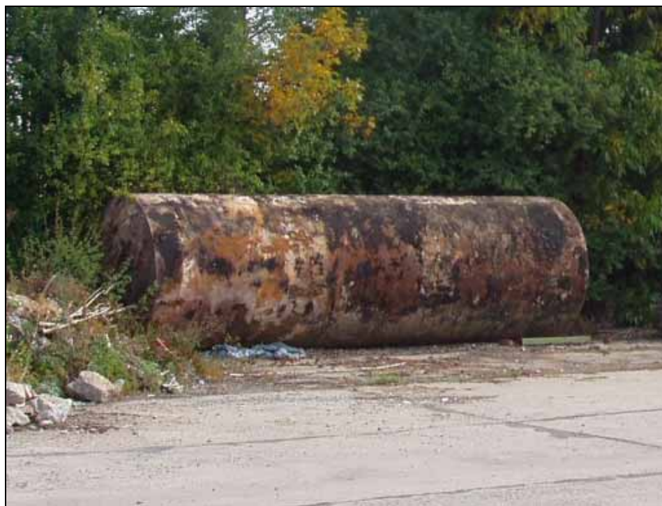
foto č. 17: Nádrž na naftu odstraněná z budovy bývalého olejového hospodářství (v průběhu její demolice).
