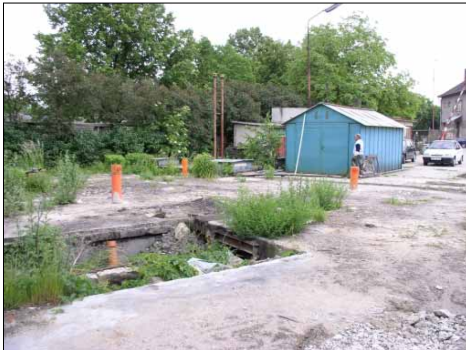
foto č. 5: Prostor projektovaný pro odtěžení – olejové hospodářství, v pozadí podzemní nádrže na naftu, sanační stanice a vjezd do areálu.
