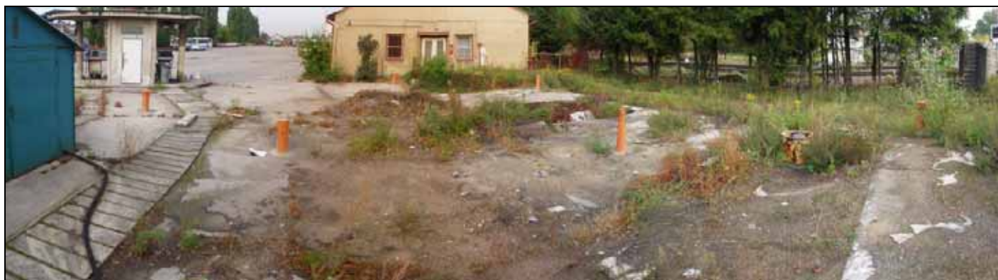
foto č. 6: Prostor projektovaný pro odtěžení – olejové hospodářství, v pozadí budova kanceláří, vlevo bývalá ČSPH a sanační stanice, vpravo koleje.
