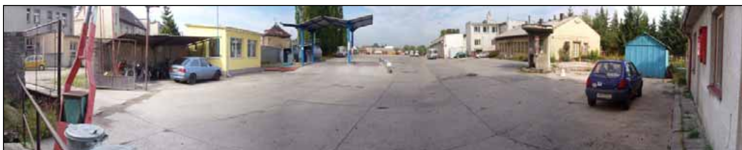
foto č. 14: Pohled na celý areál – vlevo vjezd a nová ČSPH, v pozadí parkoviště, vpravo prostor projektovaný k odtěžení (stará ČSPH, sanační stanice) a budova kanceláří (foceno od vrátnice).
