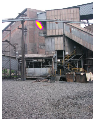
22.18. čpavkárna chemie I. šipky označují potrubí koksového prachu k přeložení
