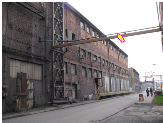
22.22. čpavkárna chemie I. šipky označují potrubí koksového prachu k přeložení
