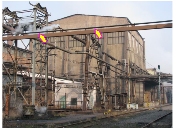
22.4. čpavkárna chemie I. jižní a východní stěna skladu síranu, šipky označují staré potrubí koksového prachu
