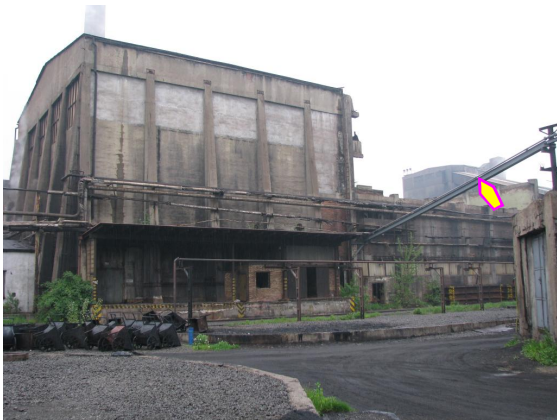
22.17. čpavkárna chemie I. šipky označují potrubí koksového prachu k přeložení
