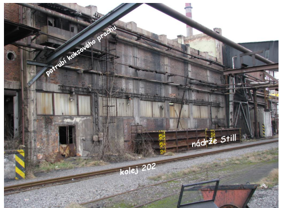
22.6. čpavkárna chemie I. východní stěna čpavkárny, vlevo nosný profil potrubí koksového prachu, dole nádrže Still s vanami
