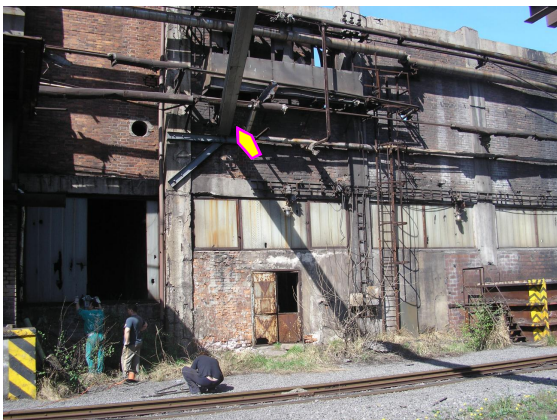
22.19. čpavkárna chemie I. šipky označují potrubí koksového prachu k přeložení
