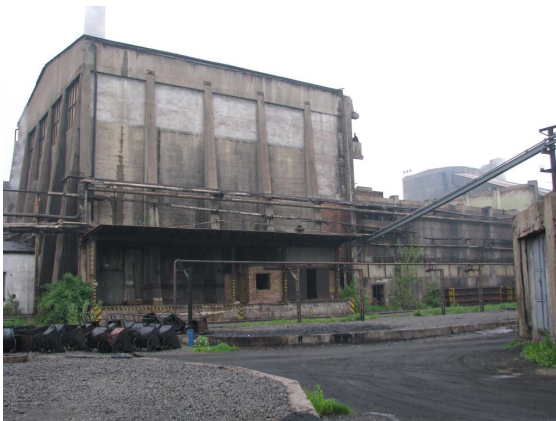
22.5. čpavkárna chemie I. budova skladu síranu, vpravo budova čpavkárny, vpravo uprostřed činné potrubí koksového prachu
