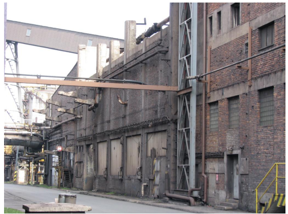
22.2. čpavkárna chemie I. západní stěna čpavkárny (pohled z jihu), uprostřed stojna kabelového mostu a potrubí koksového prachu
