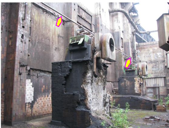
22.21. čpavkárna chemie I. šipky označují potrubí koksového prachu k přeložení
