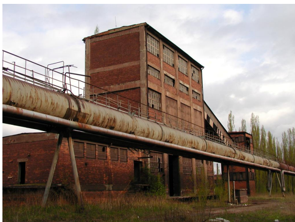
potrubí koksového plynu a parovod u předemílání koksu.
