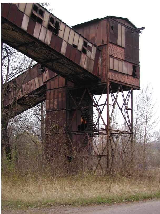
přesýpací stanice PS B1 s napínací stanicí a mosty ze SV
