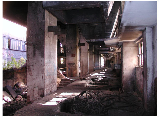
suterén směšovacích zásobníků s výsypkami
