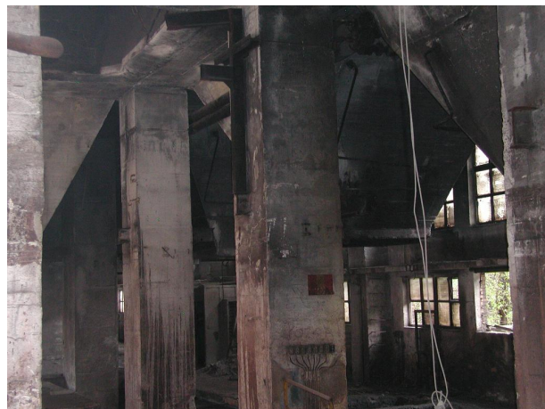
konstrukce směšovacích zásobníků
