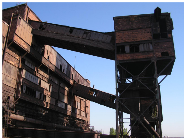
přesýpací stanice PS I a PS II nad spékárnou s mosty B5 a B51
