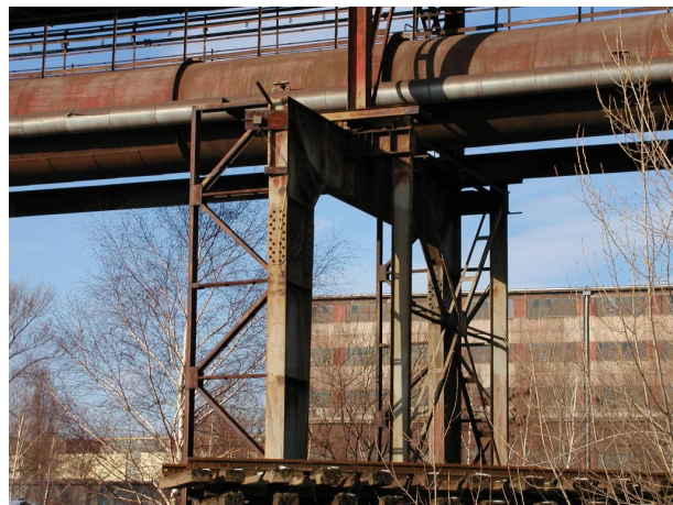
most B-C s potrubím koksového plynu a parovodem
