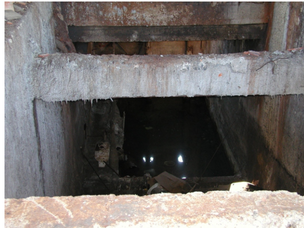
POHLED NA ZÁKLADY PODZEMNÍ ČÁSTI LICÍHO STROJE UVNITŘ BUDOVY
