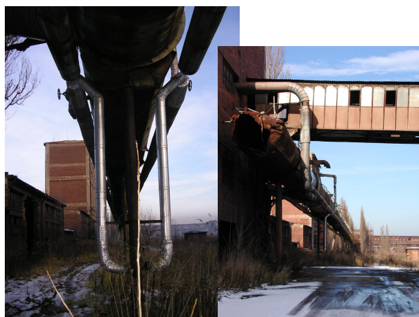
konec potrubí koksového plynu u drtírny
