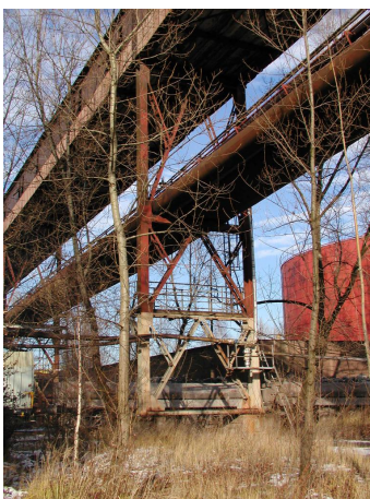
potrubní trasa koksového plynu, zemního plynu a parovodu z území aglomerace k D500
