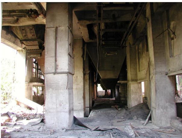
konstrukce a výsypky směšovacích zásobníků
