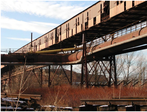
potrubní trasa koksového plynu, zemního plynu a parovodu z území aglomerace k D500
