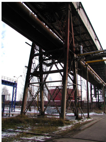
most C-D na území Divize D500, pod ním zavěšené potrubí koksového plynu, zemního plynu, parovodu
