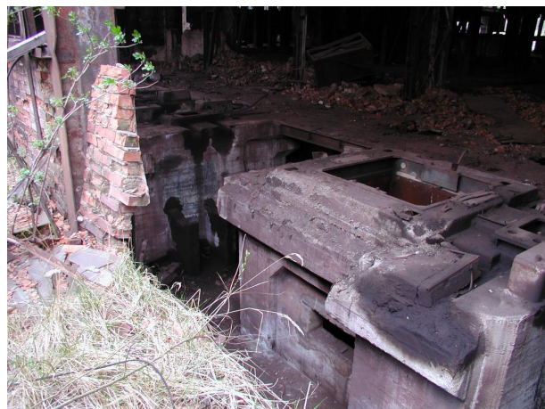
základy exhaustorů a odtah spalin
