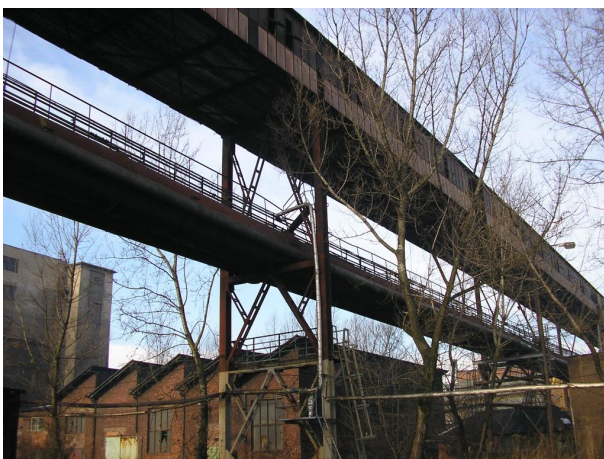
most C-D s potrubím koksového plynu a parovodem
