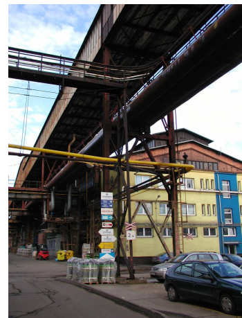
most C-D na území Divize D500, pod ním zavěšené potrubí koksového plynu, zemního plynu, parovodu
