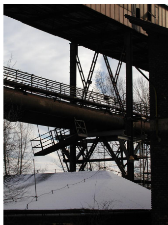
potrubní trasa koksového plynu, zemního plynu a parovodu z území aglomerace k D500
