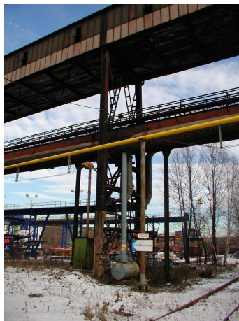
most C-D na území Divize D500, pod ním zavěšené potrubí koksového plynu, zemního plynu, parovodu
