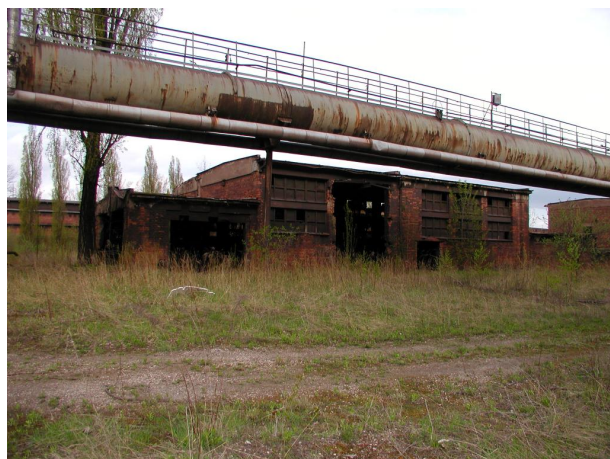
potrubí koksového plynu a parovod.
