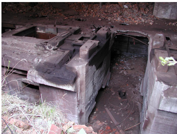
základy exhaustorů a odtah spalin
