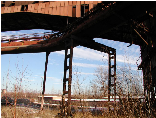
potrubní trasa koksového plynu, zemního plynu a parovodu z území aglomerace k D500
